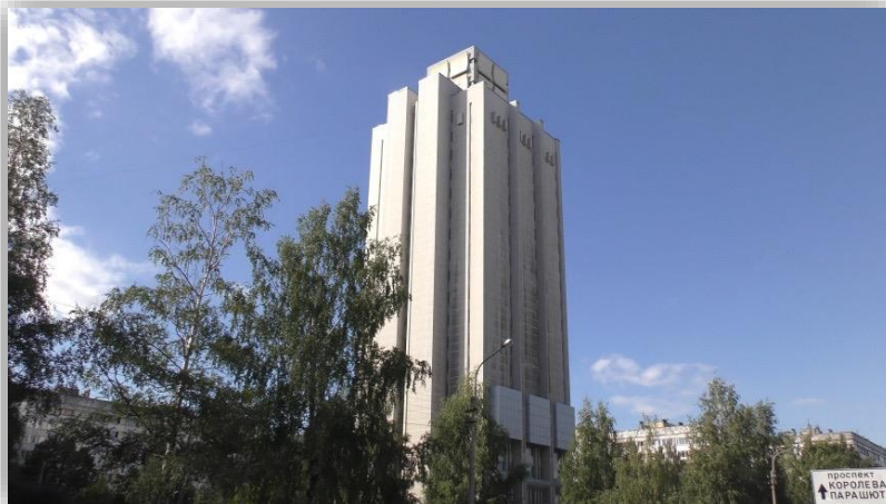
Здание Центрального архива ВМФ на Серебристом бульваре в г. Санкт-Петербурге
